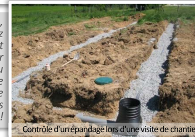
Contrôle d'un épandage lors d'une visite de chantier
